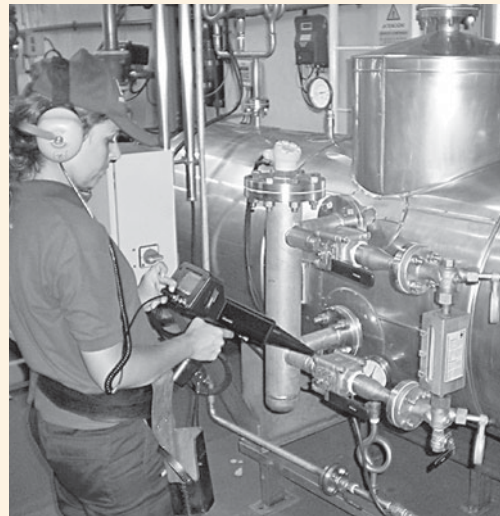
Detección de fugas de aire.
