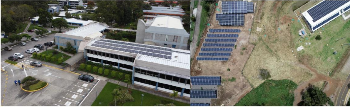
Instalaciones de paneles fotovoltaicos
