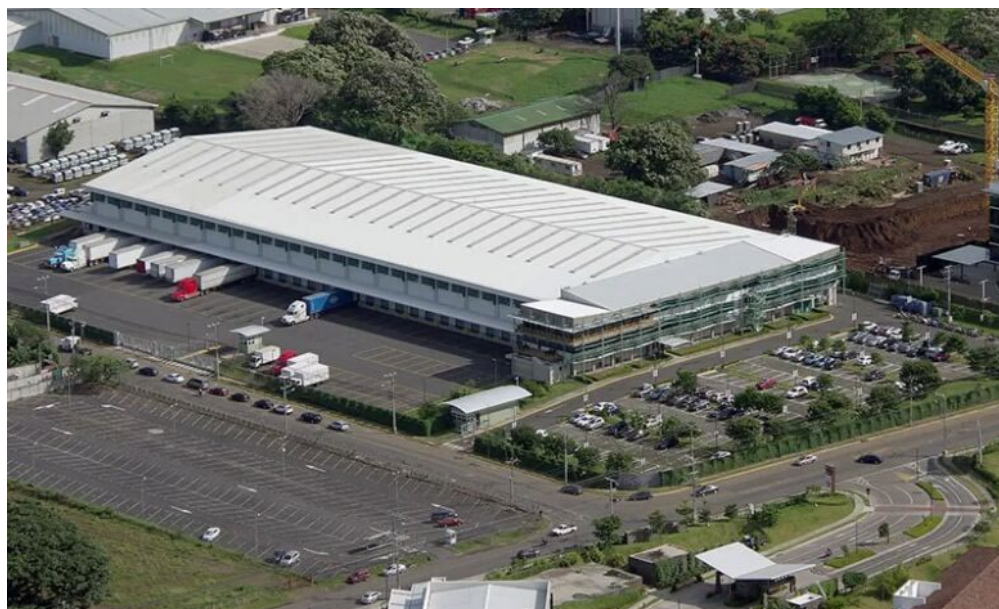
Figura 2 Centro de Distribución DIPO S.A. en la Ribera de Belén.
