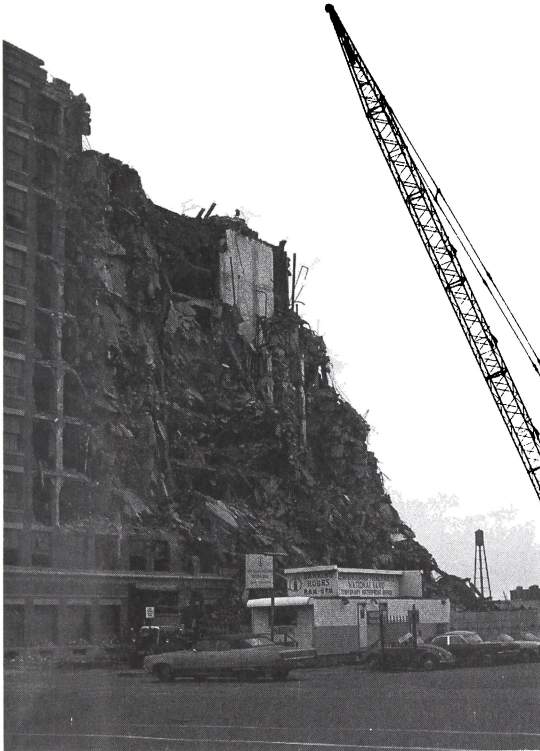
25. La demolición es una actividad altamente especializada y peligrosa, que requiere técnicas y equipos especiales (© Kevin Lynch).
