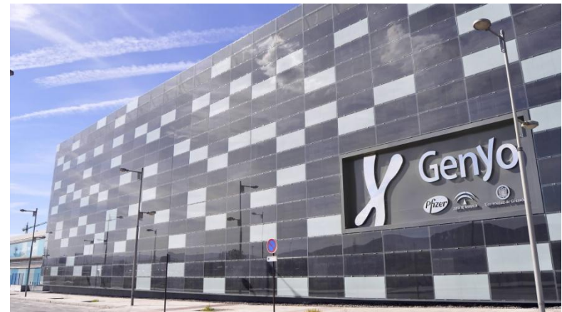
IMAGEN 120. Fachada Laboratorio GENyO
