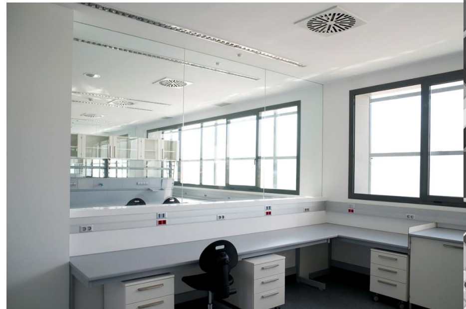
IMAGEN 127. Entradas de luz natural y uso de sistemas de ventilación en cielos, Laboratorio GENyO
