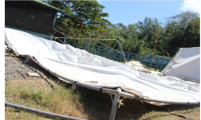
i-1.16. - Toldo colapsado a causa del Huracán Otto en La Cruz. 28 de enero, 2017.
