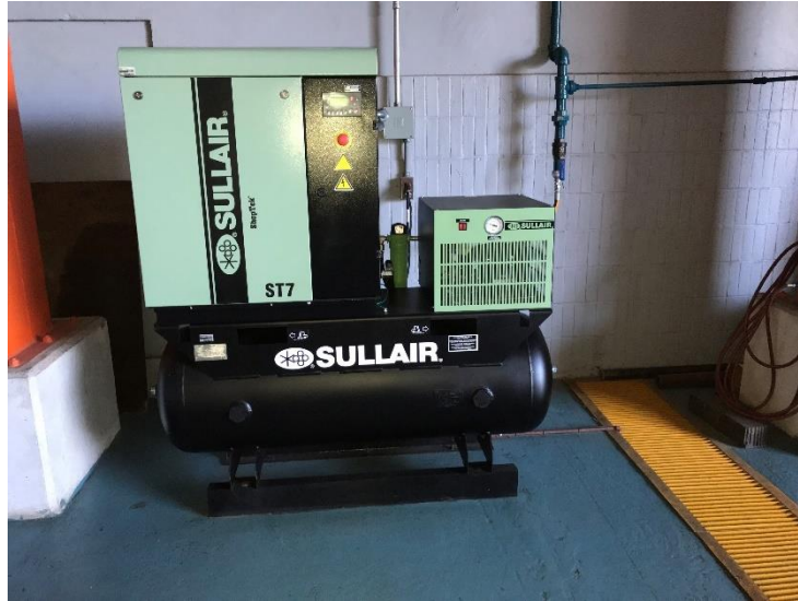
Figura 9: Compresor de aire
