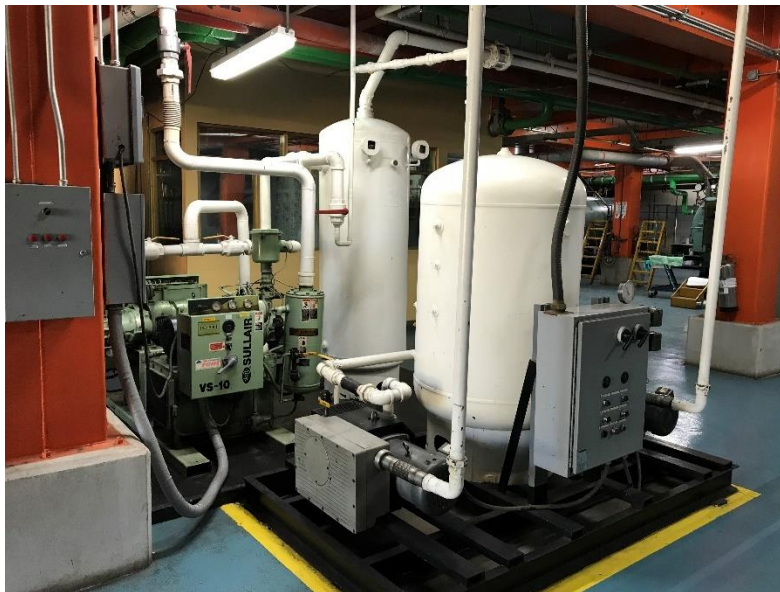
Figura 5: Generadores de vacío médico
