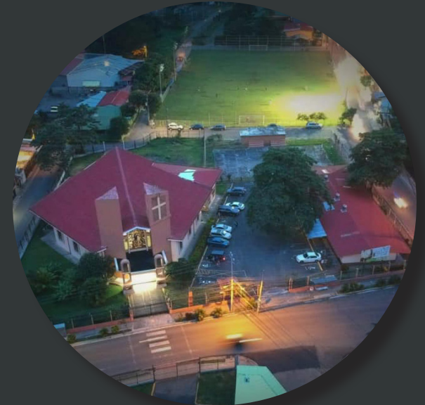
Iglesia Católica de Pozos FIG.98
