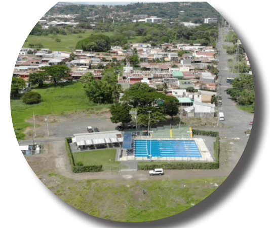
VISTA #2 HACIA EL ESTE FIG.124
