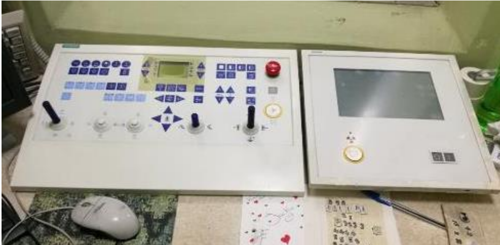
Figura 12 Panel de control de mesa de Rayos X Fuente: Elaboración propia Clínica de Coronado
