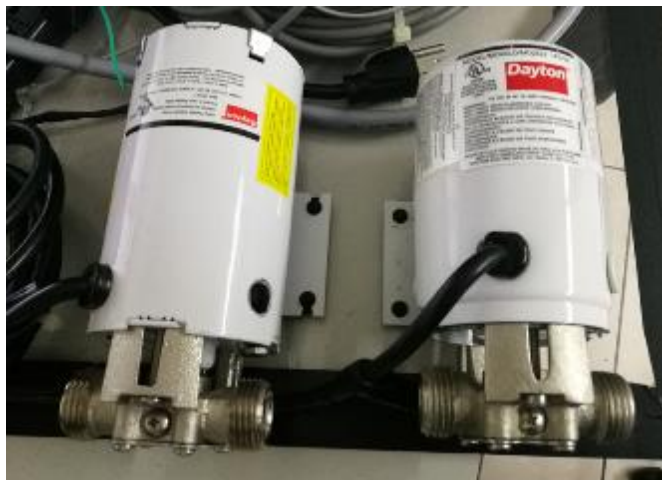
Figura 41 Bombas de regeneración marca Dayton Disponible en: Elaboración propia
