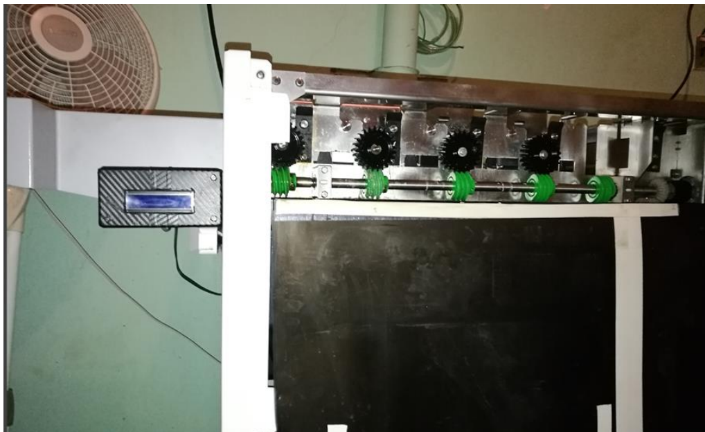
Figura 72 Montaje del display LCD Fuente: Elaboración propia
