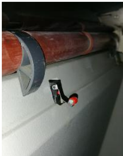
Figura 69 Colocación de interruptor de paso de placas Fuente: Elaboración propia.
