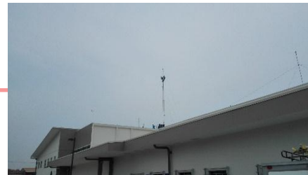
Img. 111 Pararrayos y antena.
