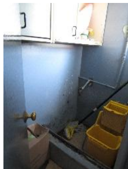
Img. 13 Cuarto de aseo
