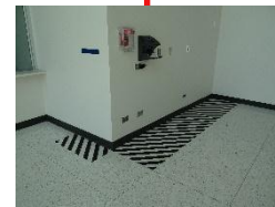
Img. 96 Control de asistencias
