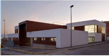
Img. 32 Vista general
