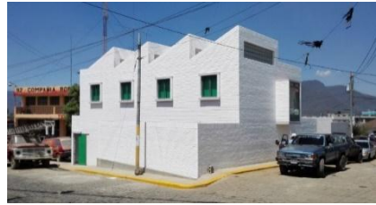
Img. 43 Vista general
