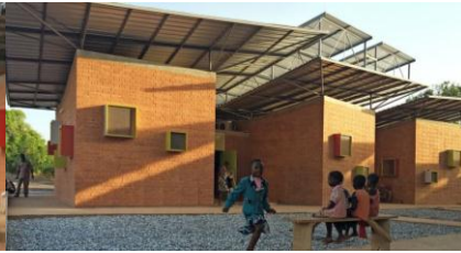
Img. 37 Fachada Norte
