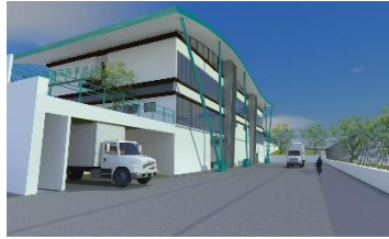
Img. 64 Zona de descarga
