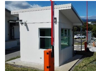
Img. 99 Caseta de guarda.
