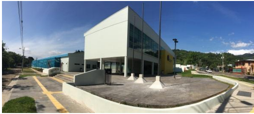
Img. 119 Vista exterior (DAI, 2015)
