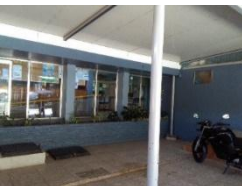
Img. 19 Acceso 1 estacionamiento
