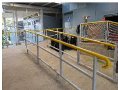
Img. 18 Acceso Emergencias
