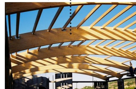
Estructura de cu- biertas en Madera
