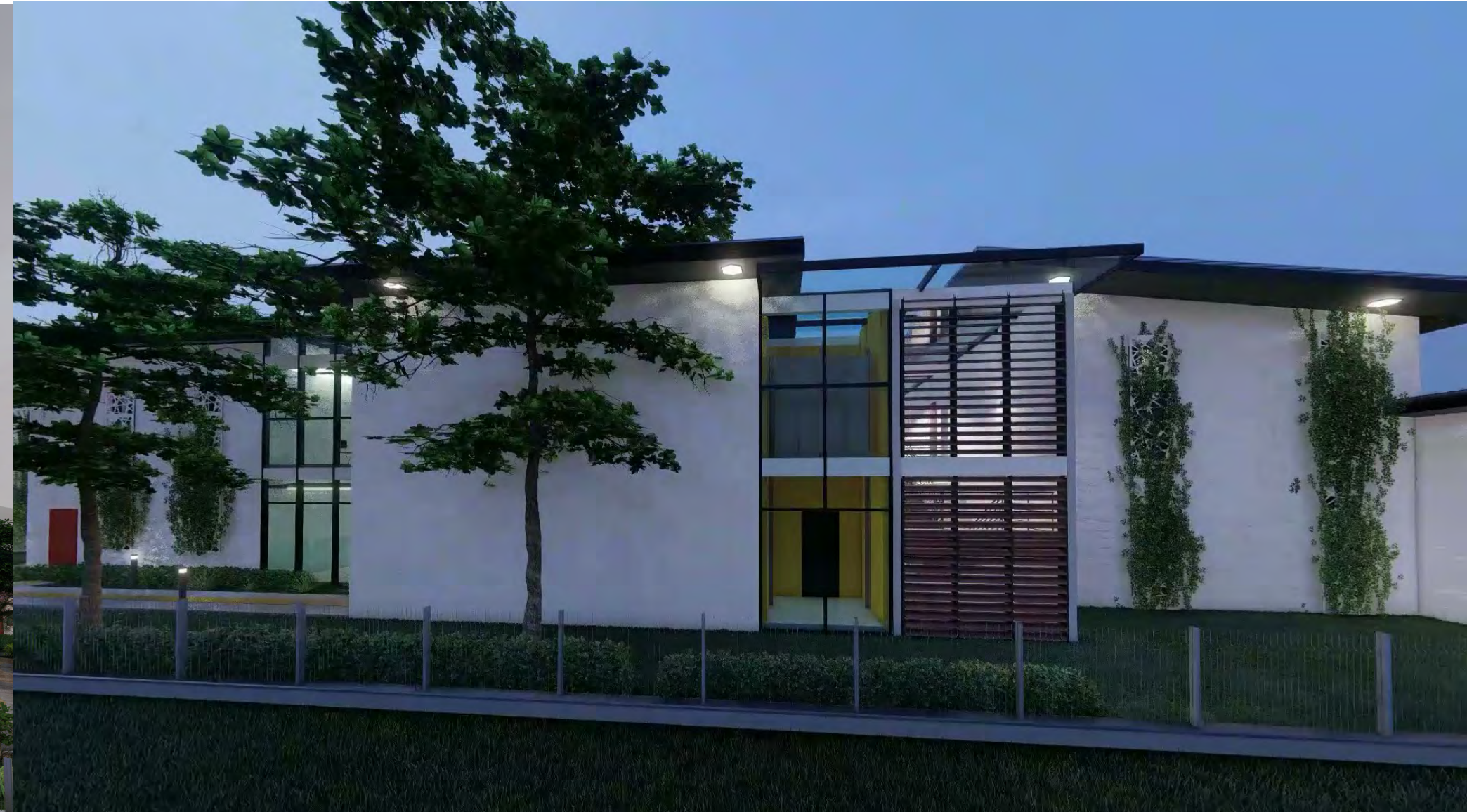
VISTA FACHADA NORTE
