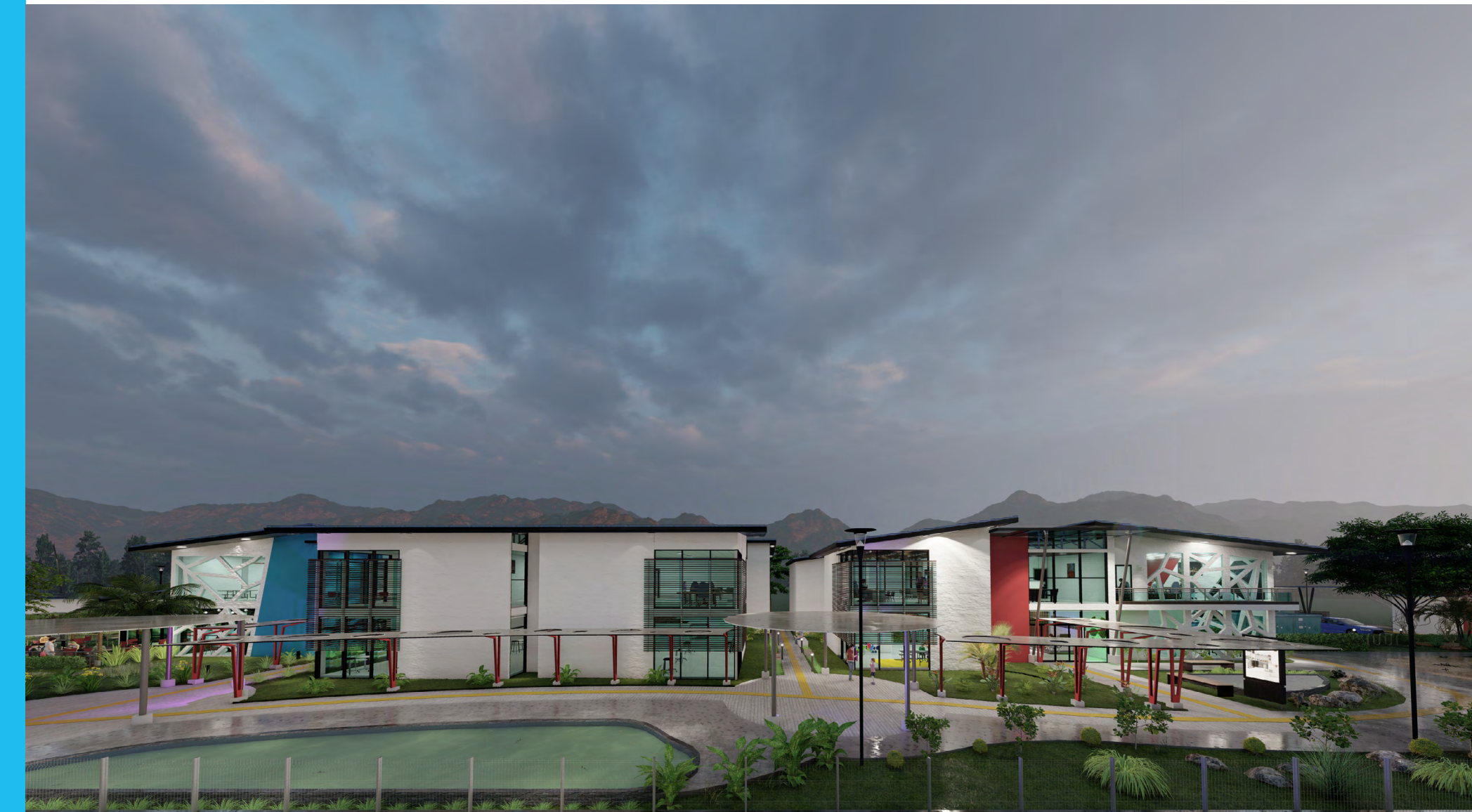
VISTA FACHADA SUR
