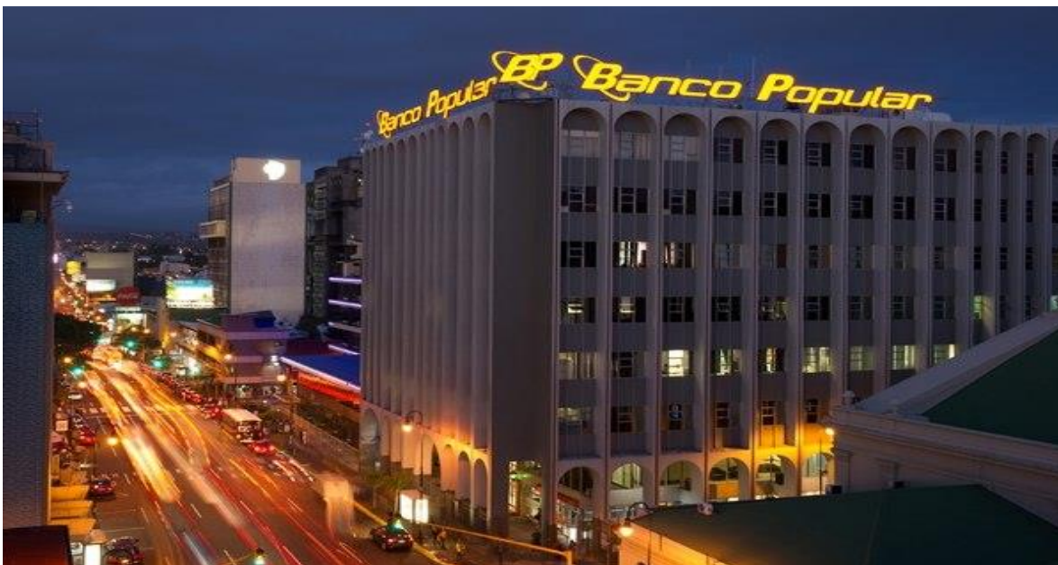
Ilustración 10. Fotografía del edificio metropolitano del Banco Popular
