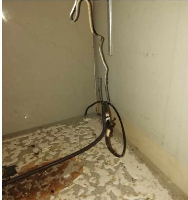
Figura 15 Instalación de resistencia eléctrica en horno actual.
