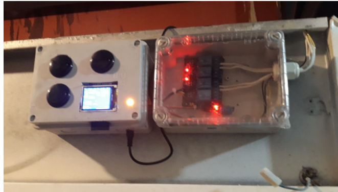
Figura 44 Instalación del dispositivo de control.
