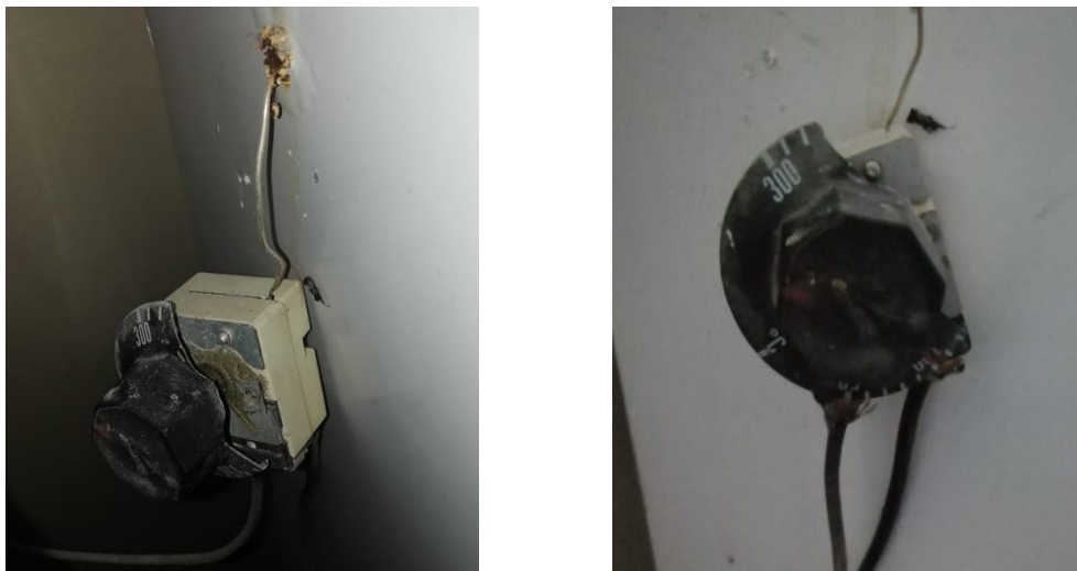
Figura 14 Estado actual del termostato en horno existente
