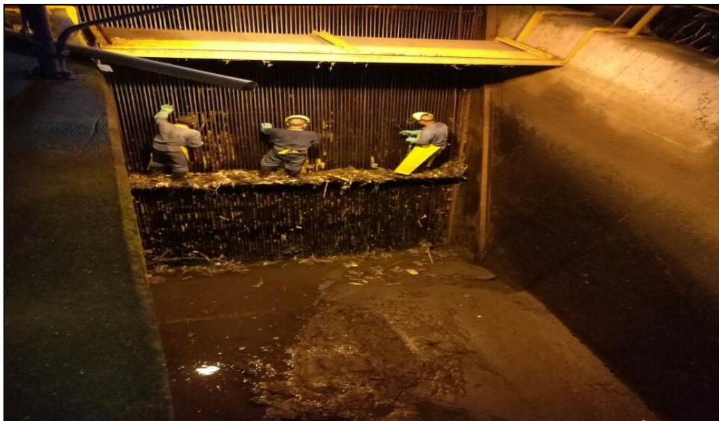
Imagen 6. Limpieza de parrilla finos tanque PH Belén.
