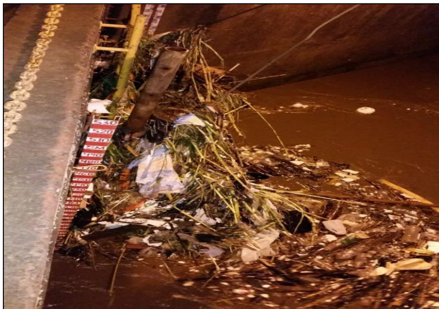
Imagen 10. Arrastre de basura en parilla de presa PH Belén.
