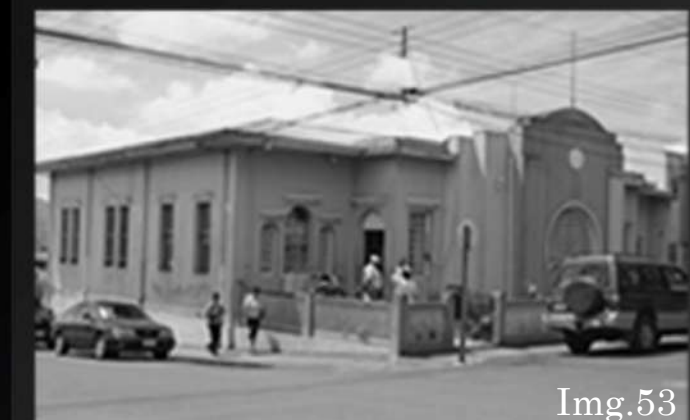
Palacio Municipal Época Constructiva: 1901-1950 Influencia Estilística Art Decó (1930-1950) Cartago, Oreamuno, San Rafael
