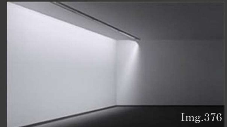
Luminaria perimetral con tubos fluorescente
