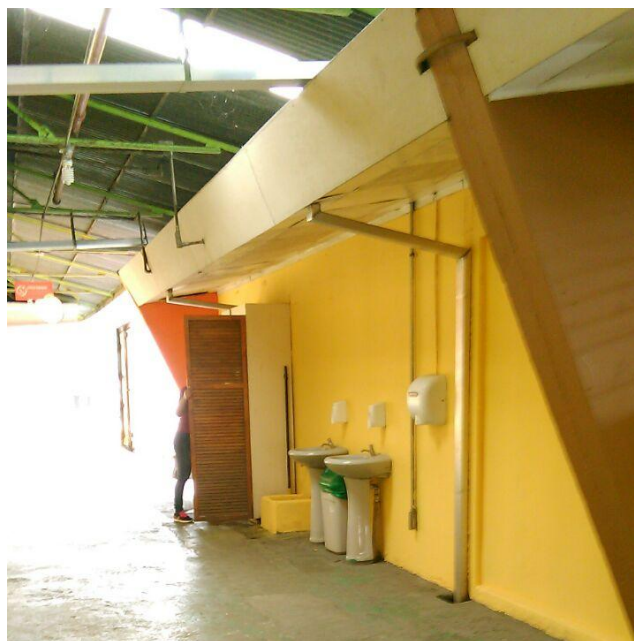
Figura N° 14: Entrada al área de preparación de alimentos
