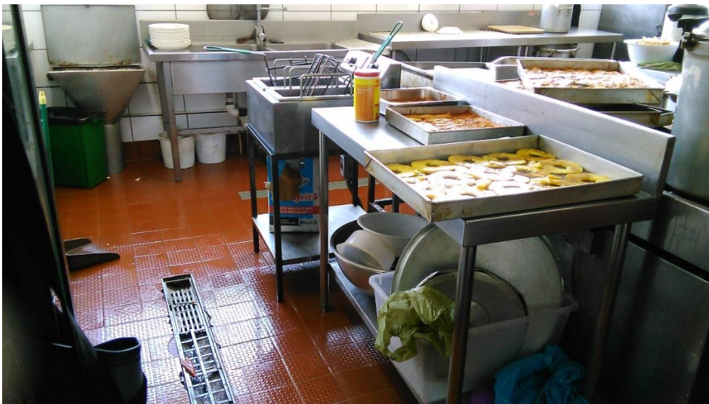
Figura N° 21: Rejilla del piso con orificios muy grandes
