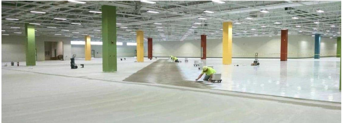
Figura 1 Aplicación de piso industrial
