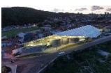
Fig. #31. Arena do Morro / Herzog & de Meuron. Plataforma Arquitectura. Recuperado de https://www.plataformaarquitectura.cl/cl/02-363667/arena-do-morro-herzog-and-de-meuron
