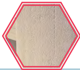
PAREDES LIVIANAS EMPASTADAS Y PINTADAS
