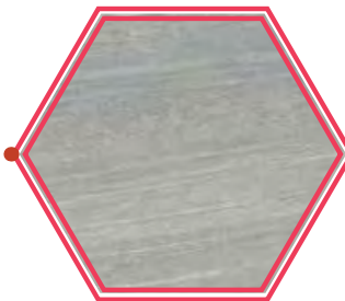
ACABADO DE CONTRAPISO EN CONCRETO LUJADO
