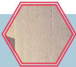
PAREDES REPELLADAS Y PINTADAS
