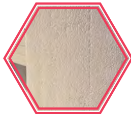
PAREDES REPELLADAS Y PINTADAS
