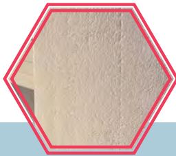
PAREDES REPELLADAS Y PINTADAS
