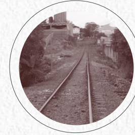
F274 . Línea del Tren Fotografía Propia
