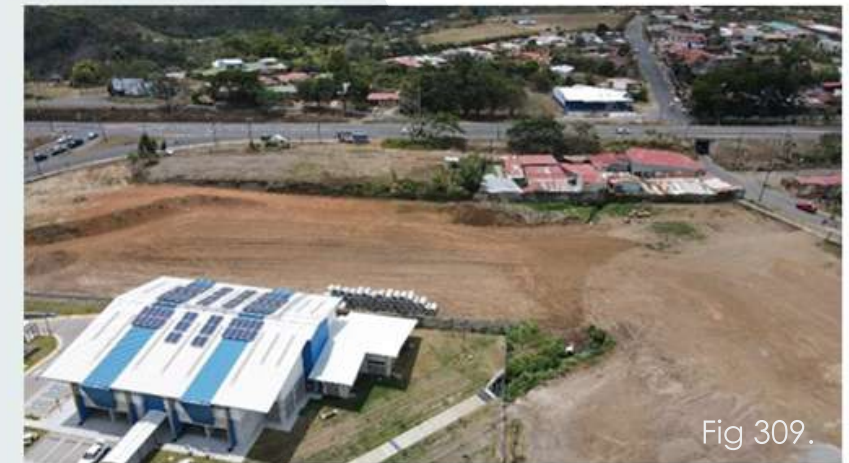
Sur Autopista Bernardo Soto
