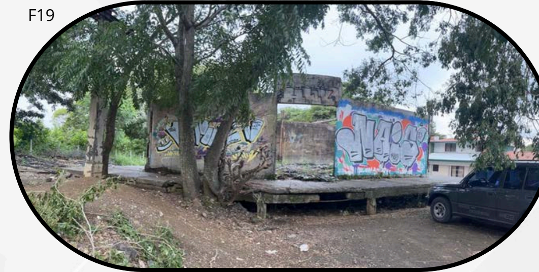
Evidencia de Vandalismo y deterioro de la Antigua Estación del Tren
