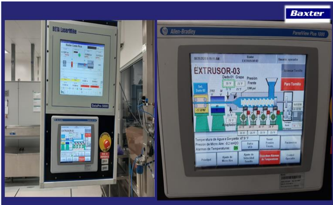
Figura 32, Panel de Control de la Extrusora
