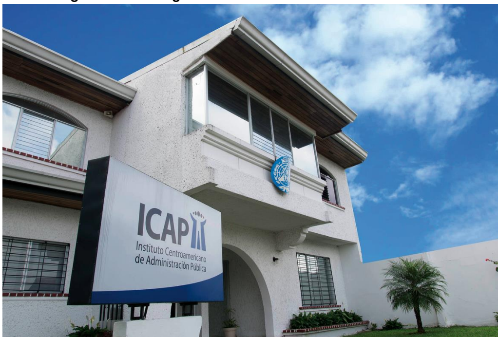
Imagen 3 Edificio oficinas centrales ICAP
