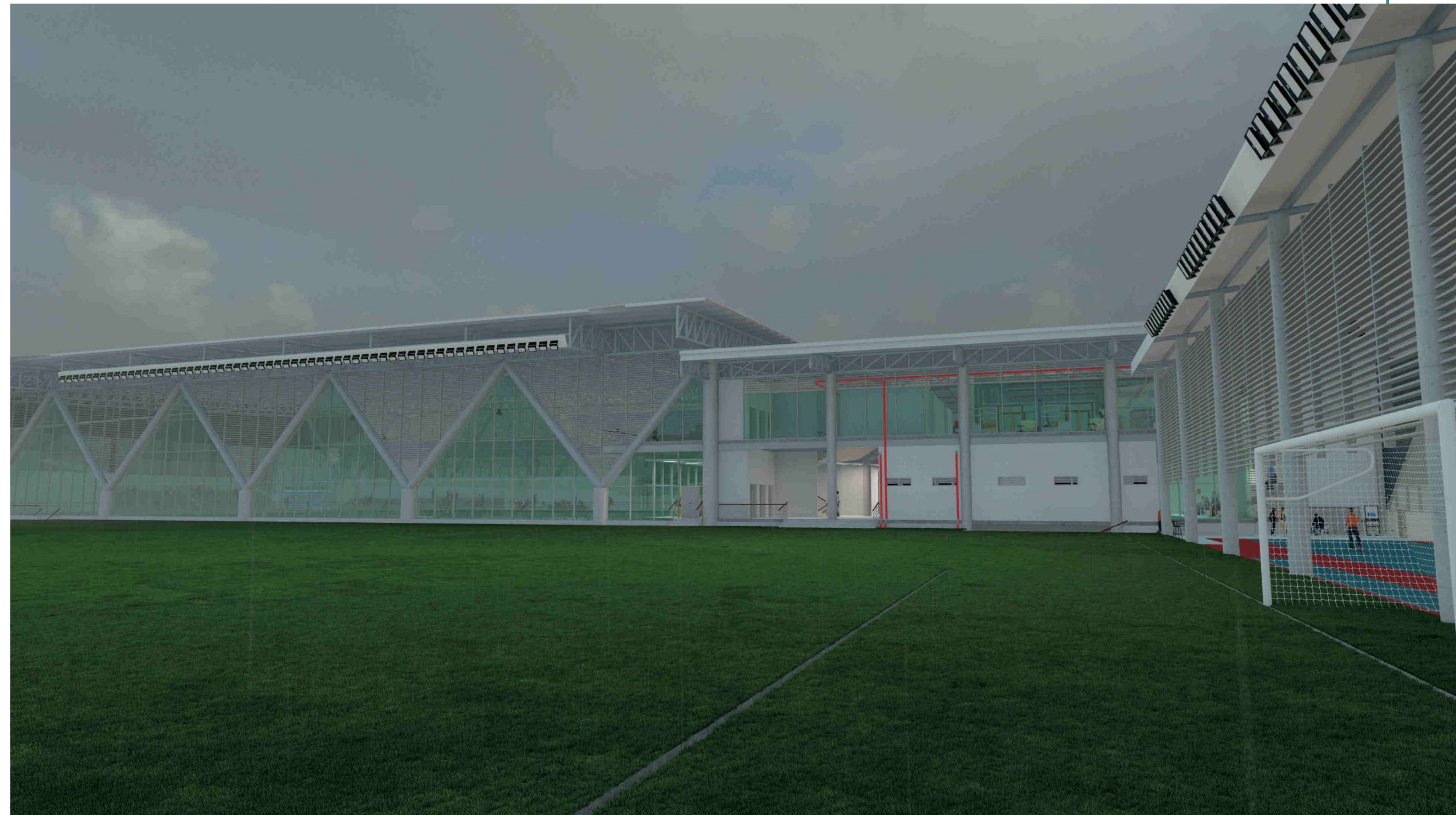
Vista externa cancha de fútbol
