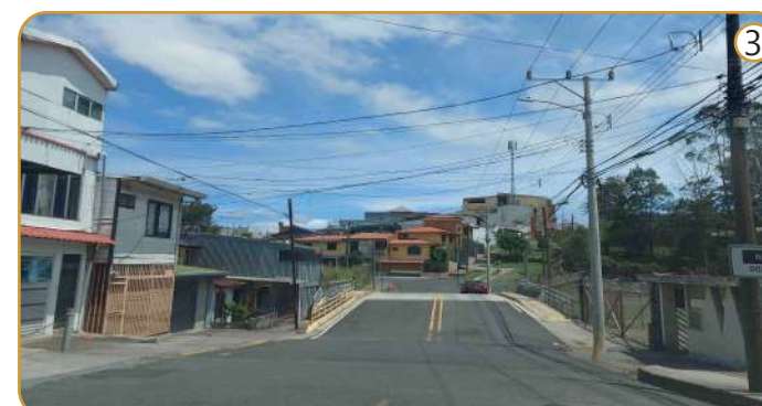
Figura propia. Vista sur a norte, calle 25.
