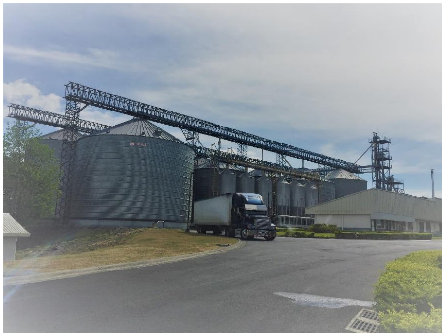
Figura 15 Silos de almacenamiento de materias primas importadas. Fuente: Elaboración propia.
