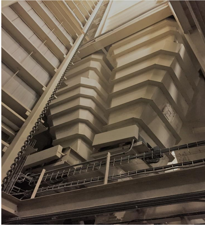
Figura 17 Celdas para almacenamiento de materias primas molidas. Fuente: Elaboración propia.
