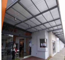
Ilustración _ 47 Vista externa Fuente: Imagen de Google
