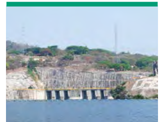
Figura 1.28 La presa de Chicoasén en Chiapas.
