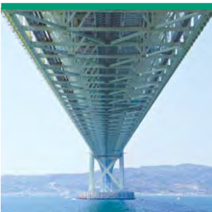
Figura 2.42 Vista del puente de suspensión Akashi en Japón.
