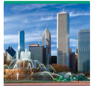
Figura 2.38 El Aon Center es una joya arquitectónica de la ciudad de Chicago y uno de los edificios más altos del mundo.
