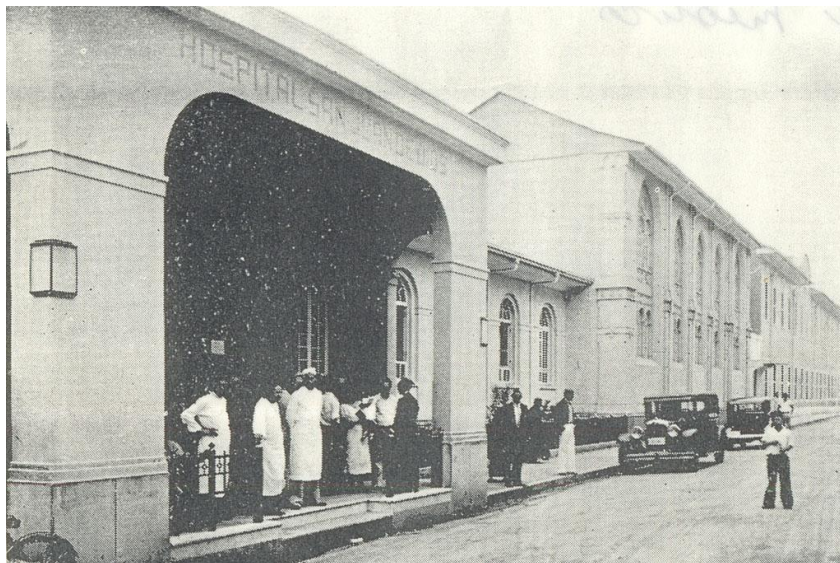
Ilustración 2 Hospital San Juan de Dios
