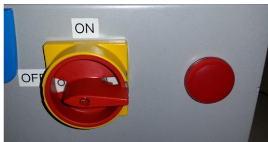
Figura 69. Switch de emergencia y habilitación de voltaje y luz indicadora
