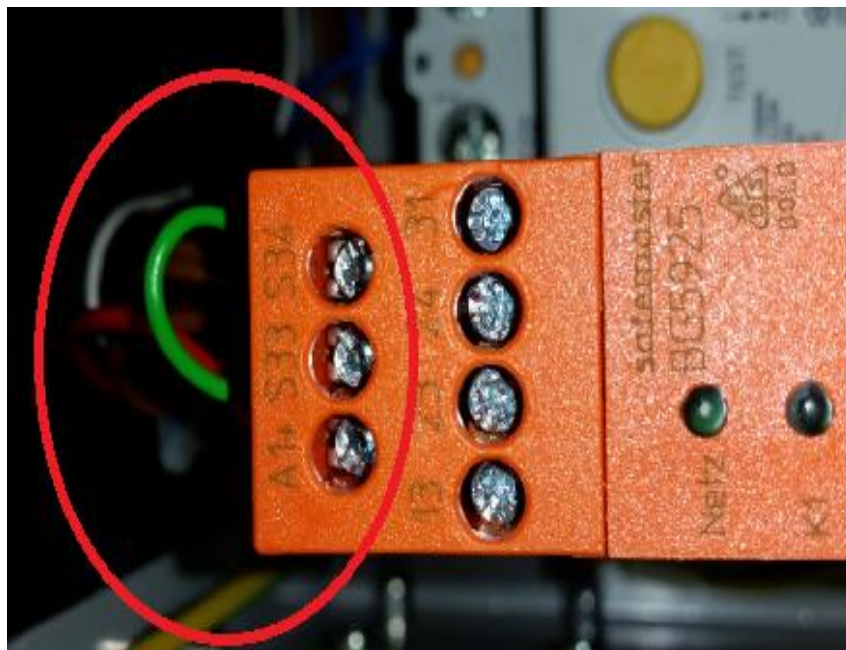
Figura 27. Colocación de puente S33 y S34
