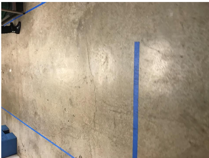
Figura 4. Contrapiso del Servicio de alimentación de Coopervision, 2019
