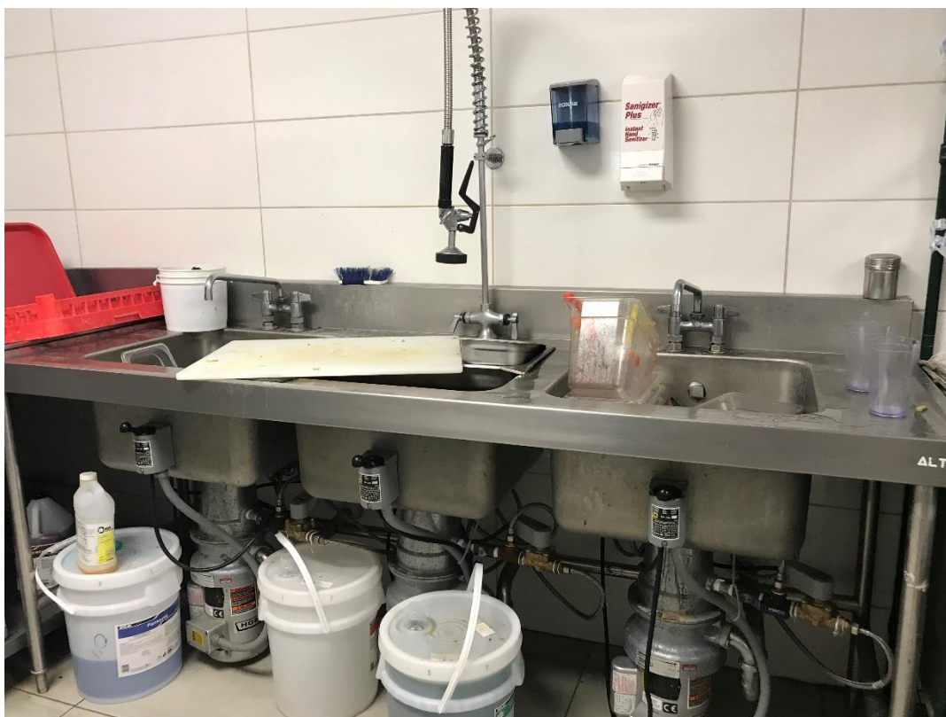
Figura 6. Fregadero del Servicio de alimentación de Coopervision, 2019
