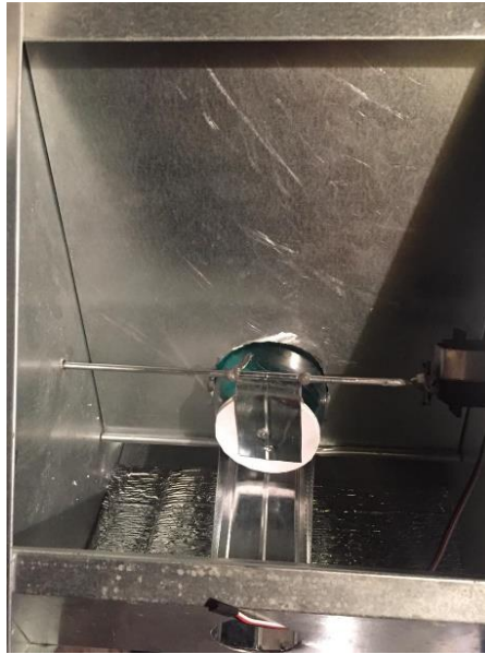
Figura 42 Montaje del servomotor
