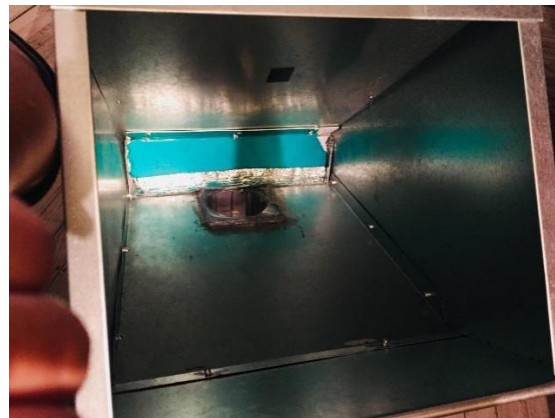
Figura 41 Adaptación del tubo PVC
