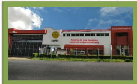
Figura 102 Estación de Bomberos de Pavas
