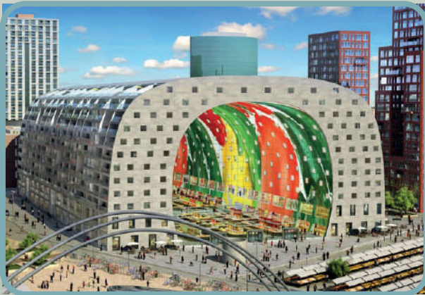
Imagen 2. Mercado Markthal Rotterdam, Holanda. Tomada de (Rotterdam Market Hall. MVRDV, 2014)
