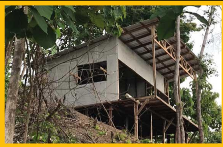
Vivienda montada sobre pilotes, estructura de madera forrada en plywood F-156
