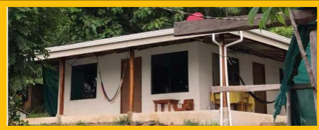
Vivienda hecha con material liviano, se utilizo cerramiento en F-157 ventanas vidrio
