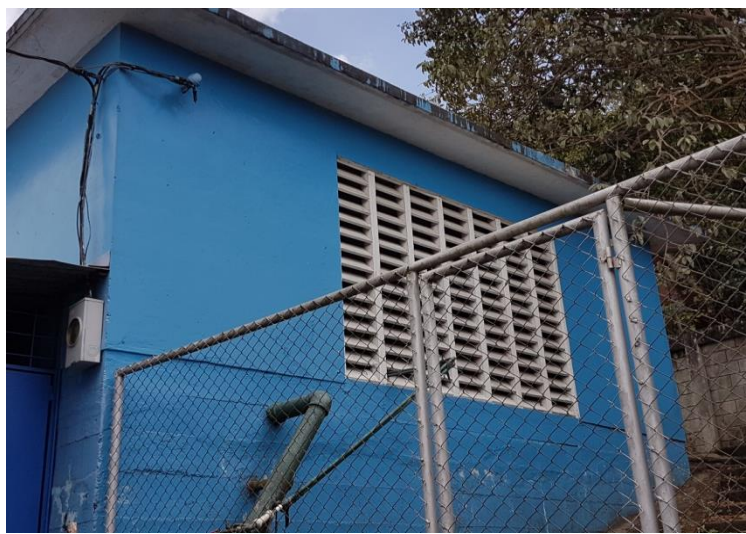
Figura 5. Tanque de captación de agua La Colina.
