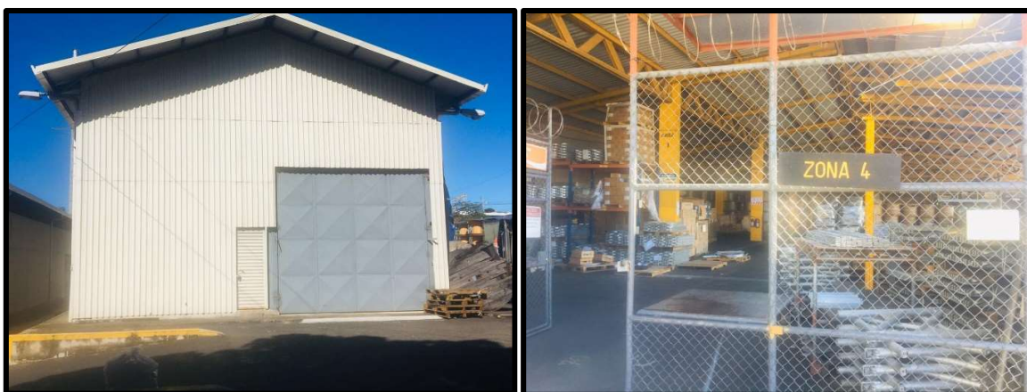
Figura N° 8 Portones de seguridad
