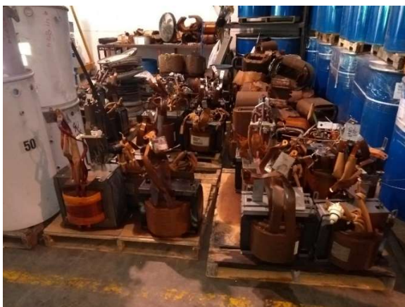
Imagen 3. Núcleos de transformadores
