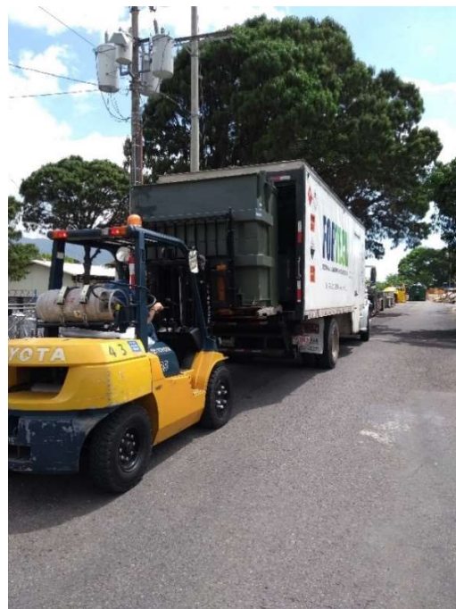
Imagen 2. Entrega de transformadores a la empresa Fortech
