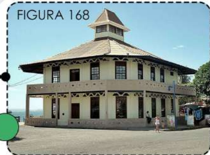
Capitanía del Puerto Época Constructiva: 1901-1950
