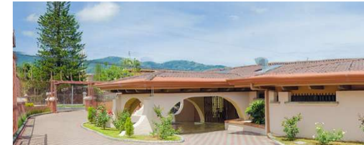
Figura 32. Ingreso principal de la Residencia Geriátrica Santa Clara.
