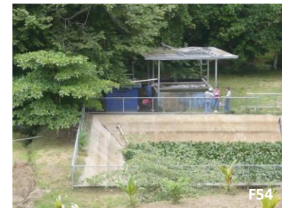
Laguna Oxidación Lixiviados.
