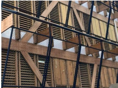
Sistema de paneles metálicos en tubo negro, malla ciclón y policarbonato como Parasoles y Doble Envolverte
