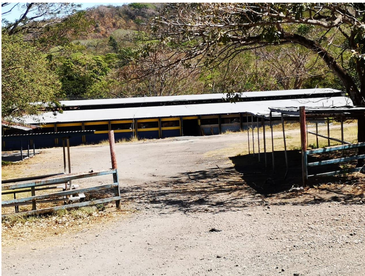
Imagen 1: Vista externa del CRRV
