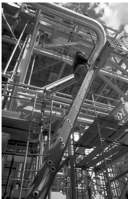
Figura 4.2. Andamiaje metálico.
