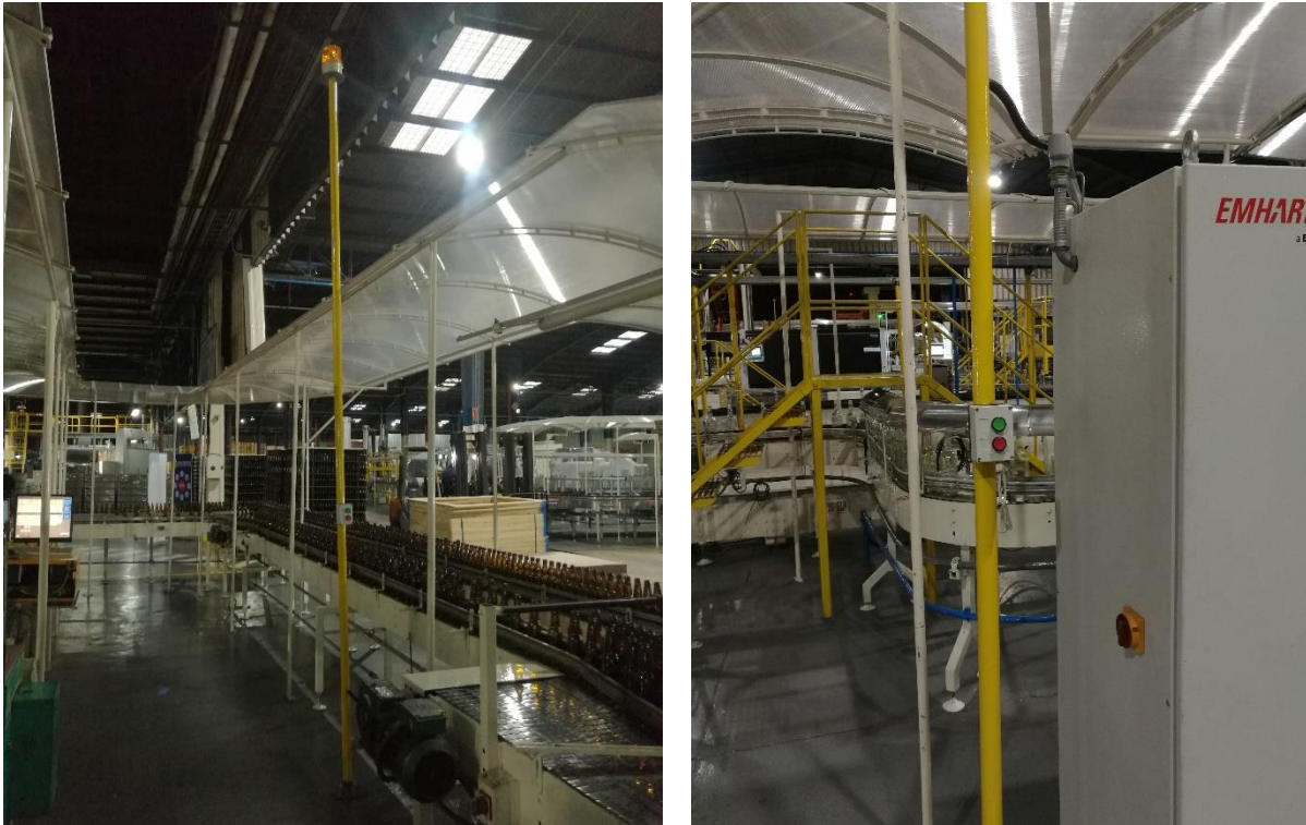
Figura 41. Sogas luminosas instaladas y terminadas. Fuente: El Autor.
