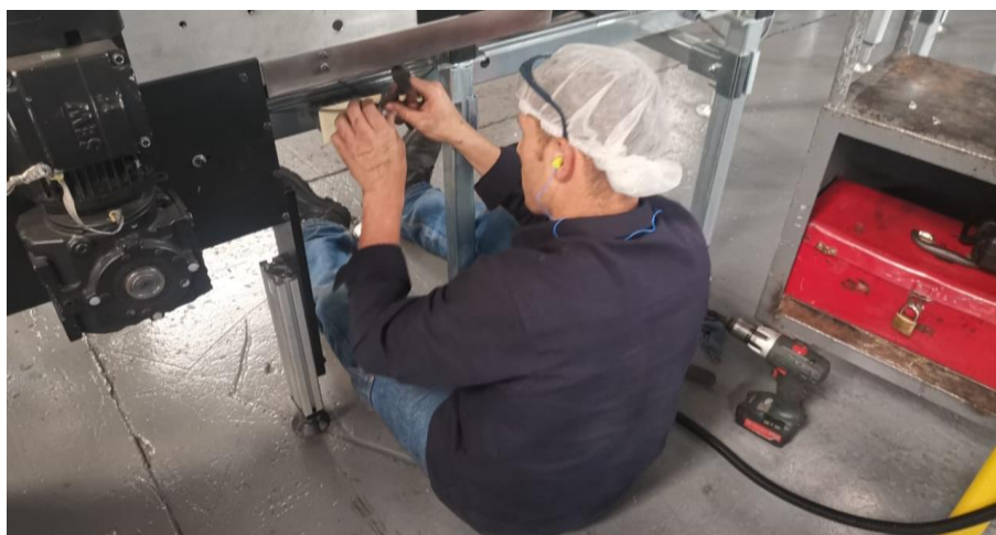
Figura 36. Instalación de la soga de la línea 201. Fuente: El Autor.
