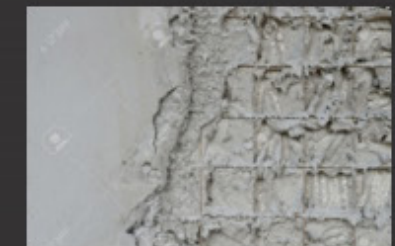
Concreto en Paredes
