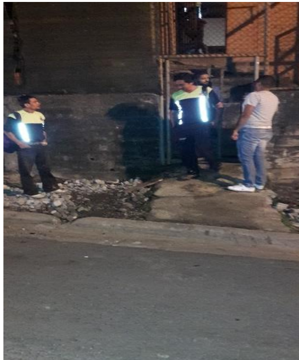
Ilustración 6. Inicio de labores 4 a.m.
