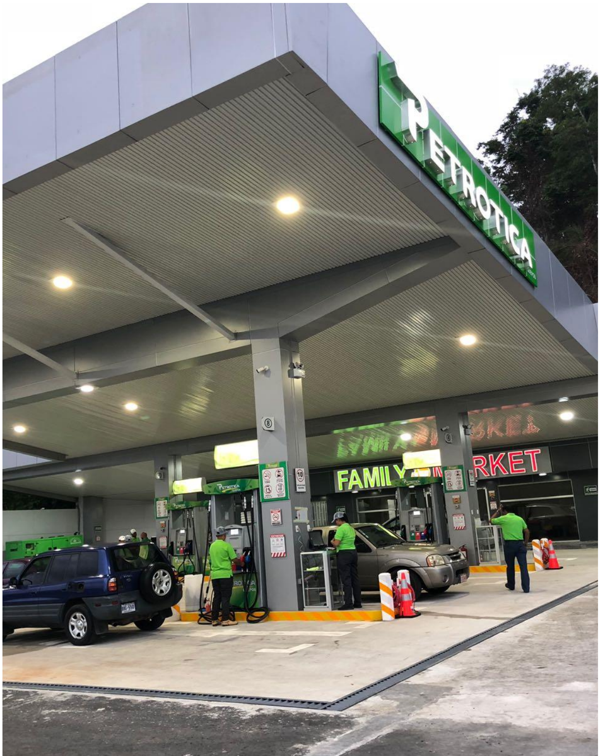
Apéndice 2. Las pista con su respectivo dispensador de combustible.
