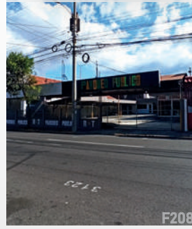
ESTACIONAMIENTO PÚBLICO O PRIVADO
