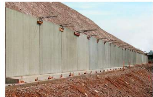
MUROS DE CONTENCIÓN
