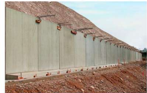
MUROS DE CONTENCIÓN
