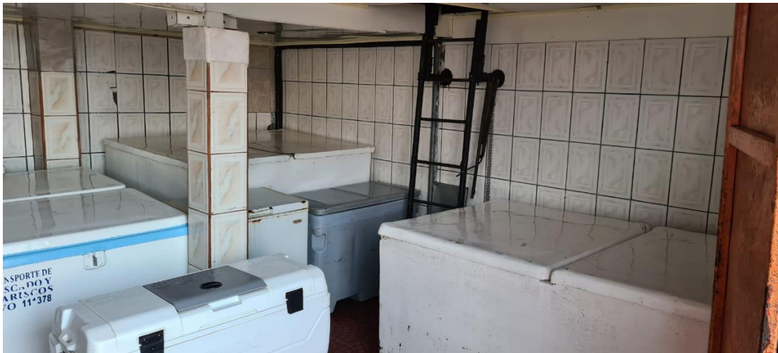
Ilustración N°4: Arreglos de infraestructura. Enchapado
